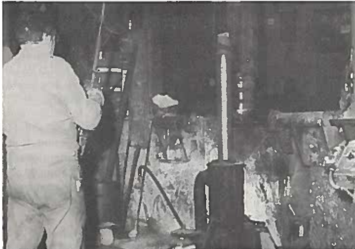
COULEE D'UNE BILLETTE M. HOUDE l'extrait de la lingotière
